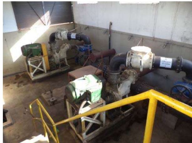
Figura 26 – Conjuntos moto-bombas
