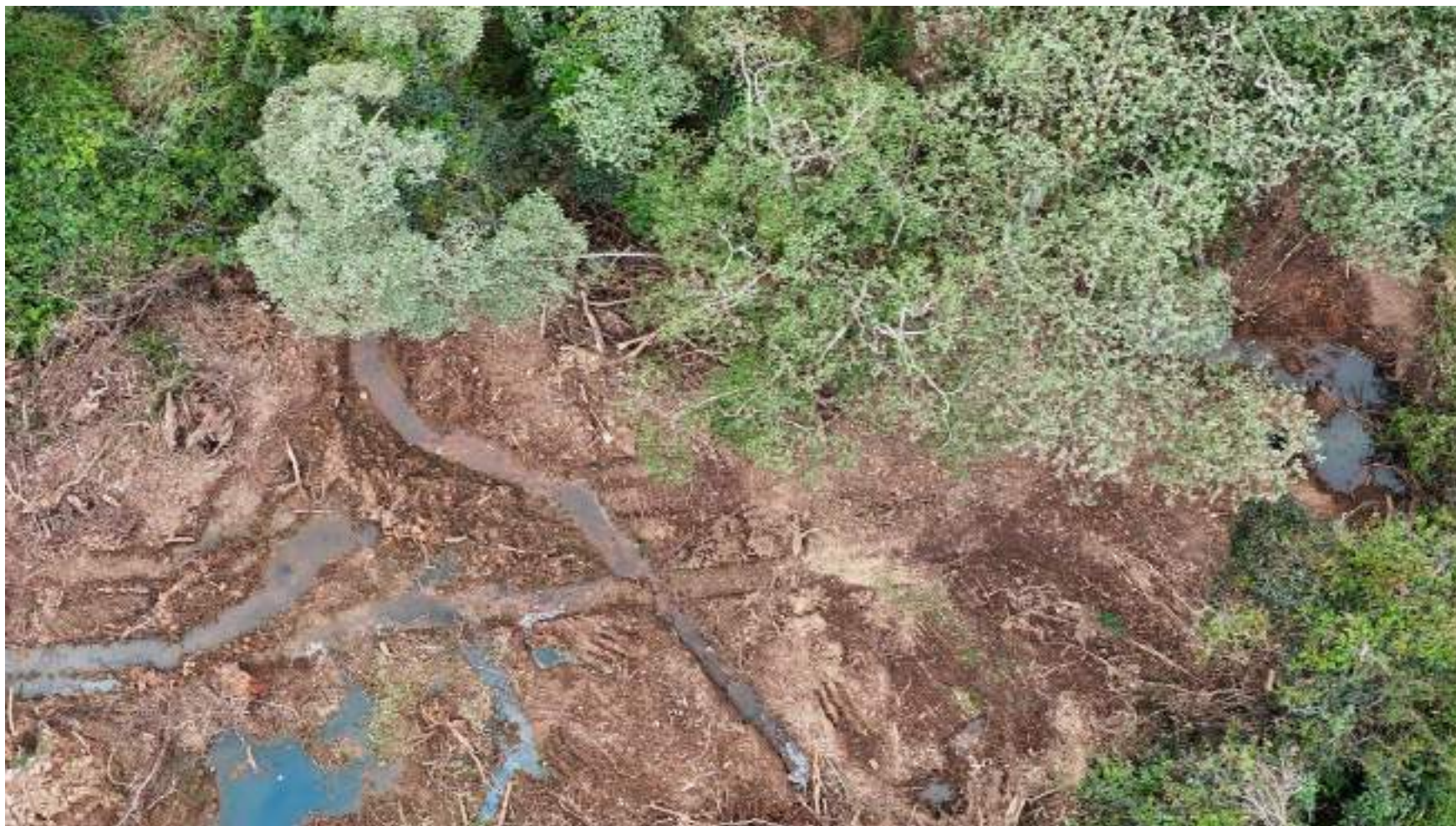
Foto 22 — Vista complementar — detalhe final da área de intervenção, com visualização das condições do terreno pós-escavação.
