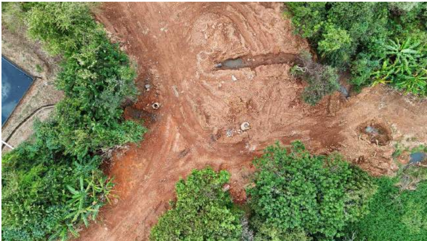
Foto 06 — Vista oblíqua do trecho — detalhe dos poços de visita existentes e da vala aberta para assentamento do novo emissário PEAD DN 600 mm.
