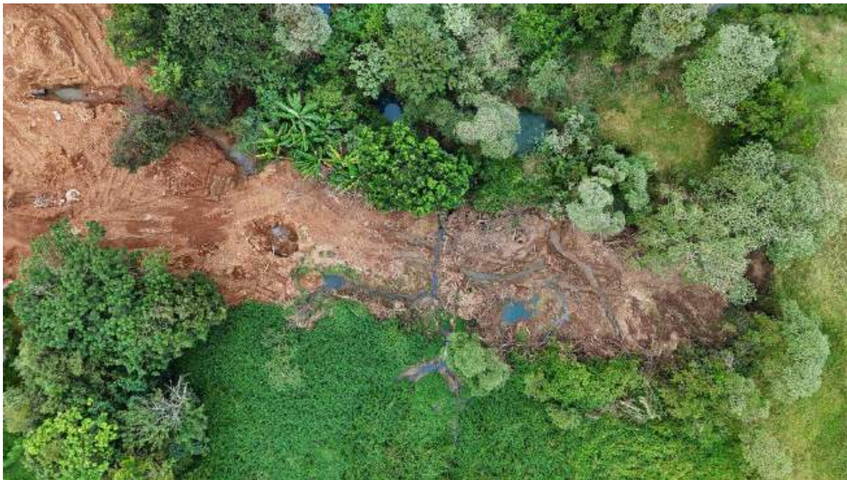
Foto 04 — Área de trabalho — visualização da frente de escavação executada pelo SAAE Passos com equipamento próprio e identificação dos poços de visita existentes.
