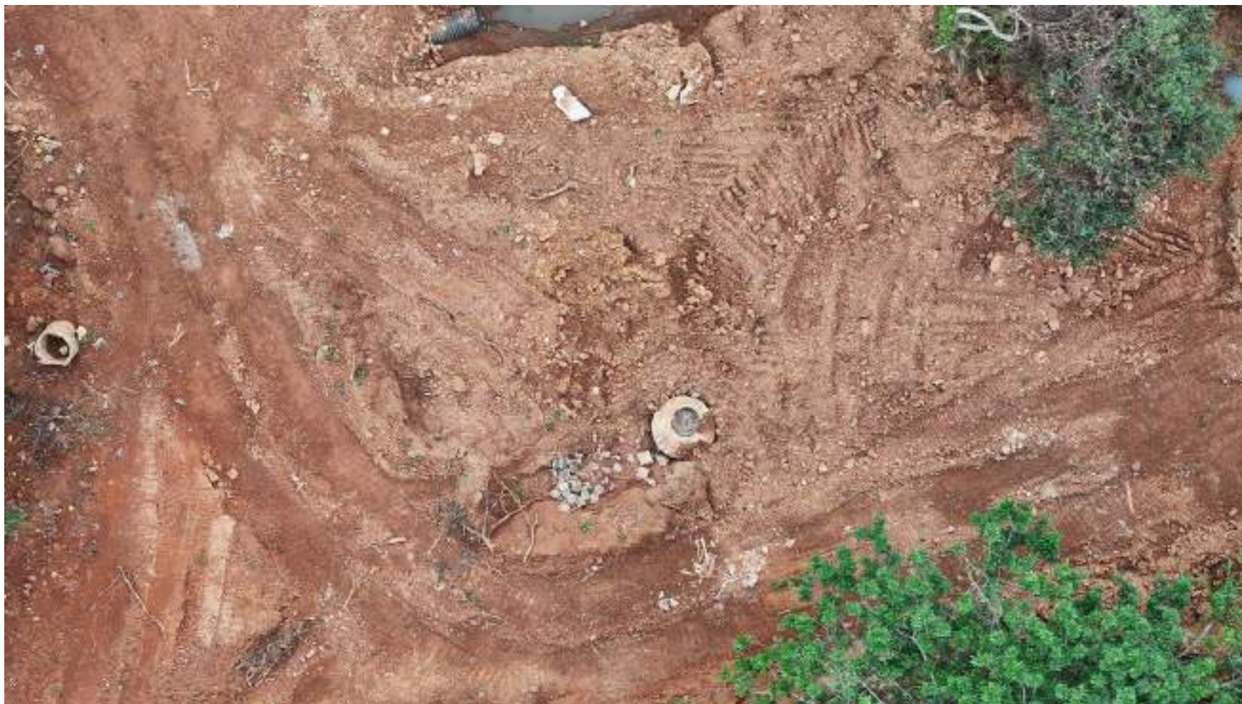
Foto 26 — Vista final — registro panorâmico de encerramento do levantamento aéreo do trecho do emissário de esgoto — Distrito Industrial 1.
