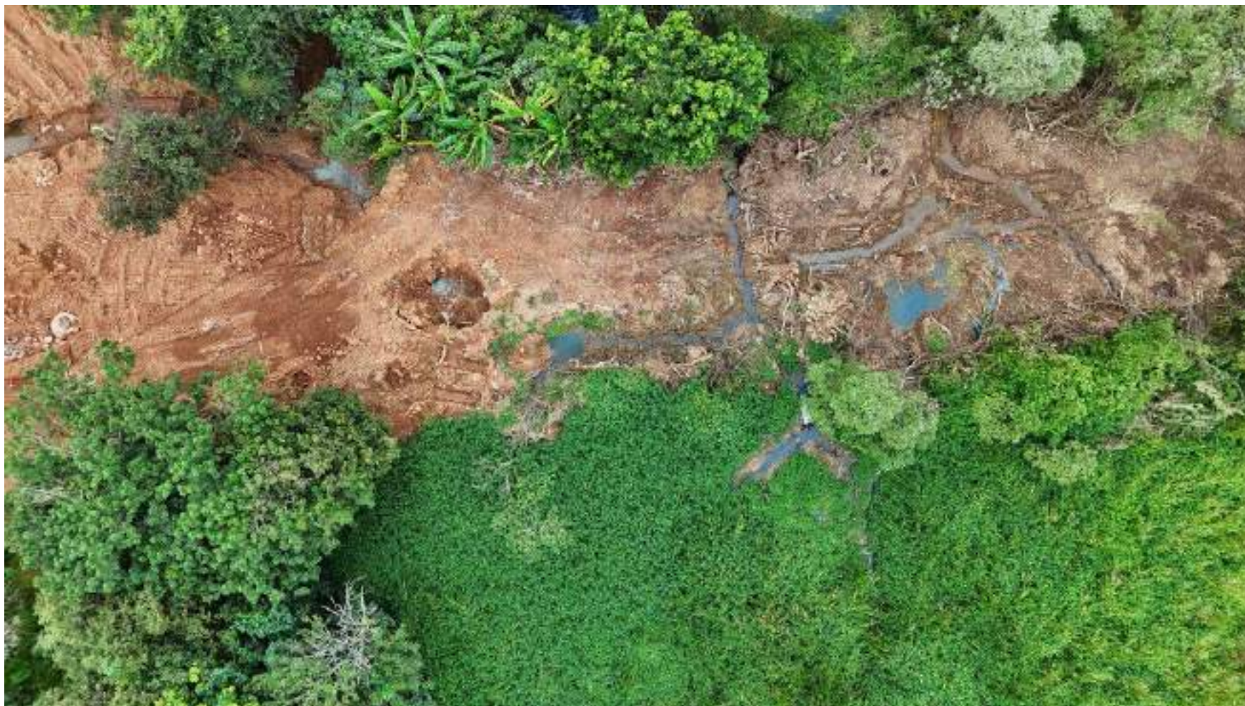
Foto 12 — Detalhe dos poços de visita existentes — ambos os PVs identificados e expostos, prontos para interligação ao novo emissário PEAD DN 600 mm.
