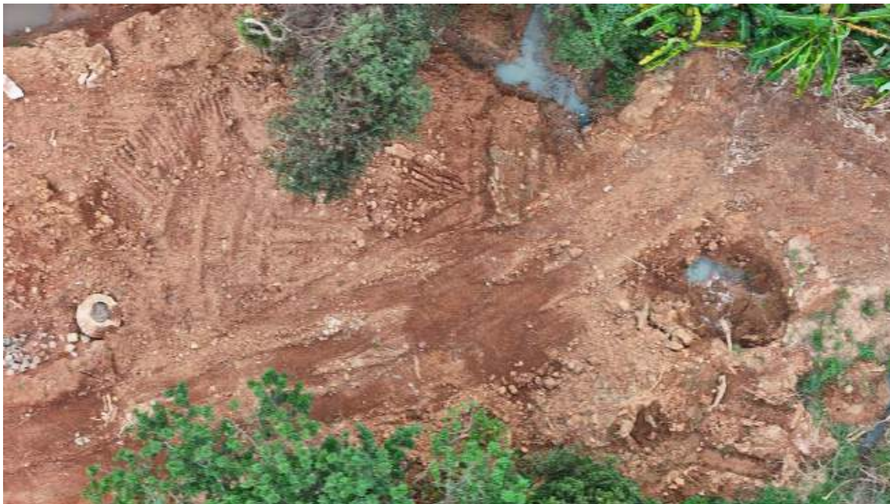
Foto 25 — Vista complementar — registro complementar para composição do relatório fotográfico técnico do emissário.
