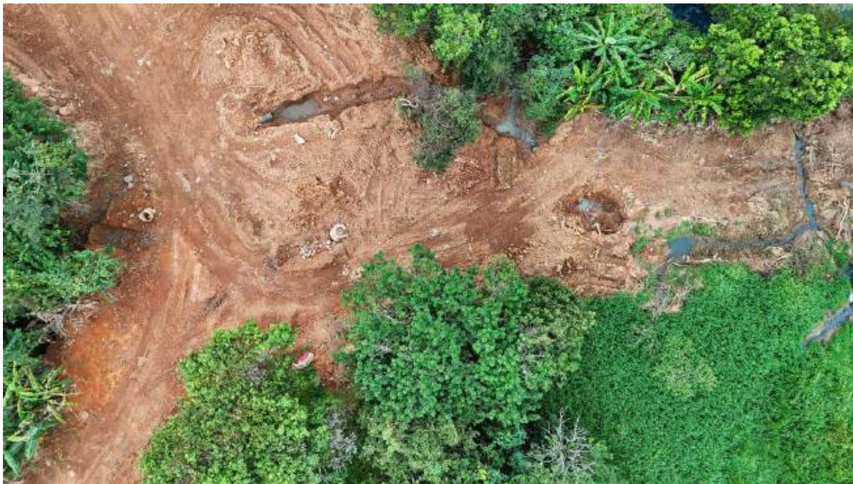
Foto 08 — Vista aérea — identificação de acúmulo de efluente e caracterização das avarias da tubulação existente, justificando a urgência da substituição.
