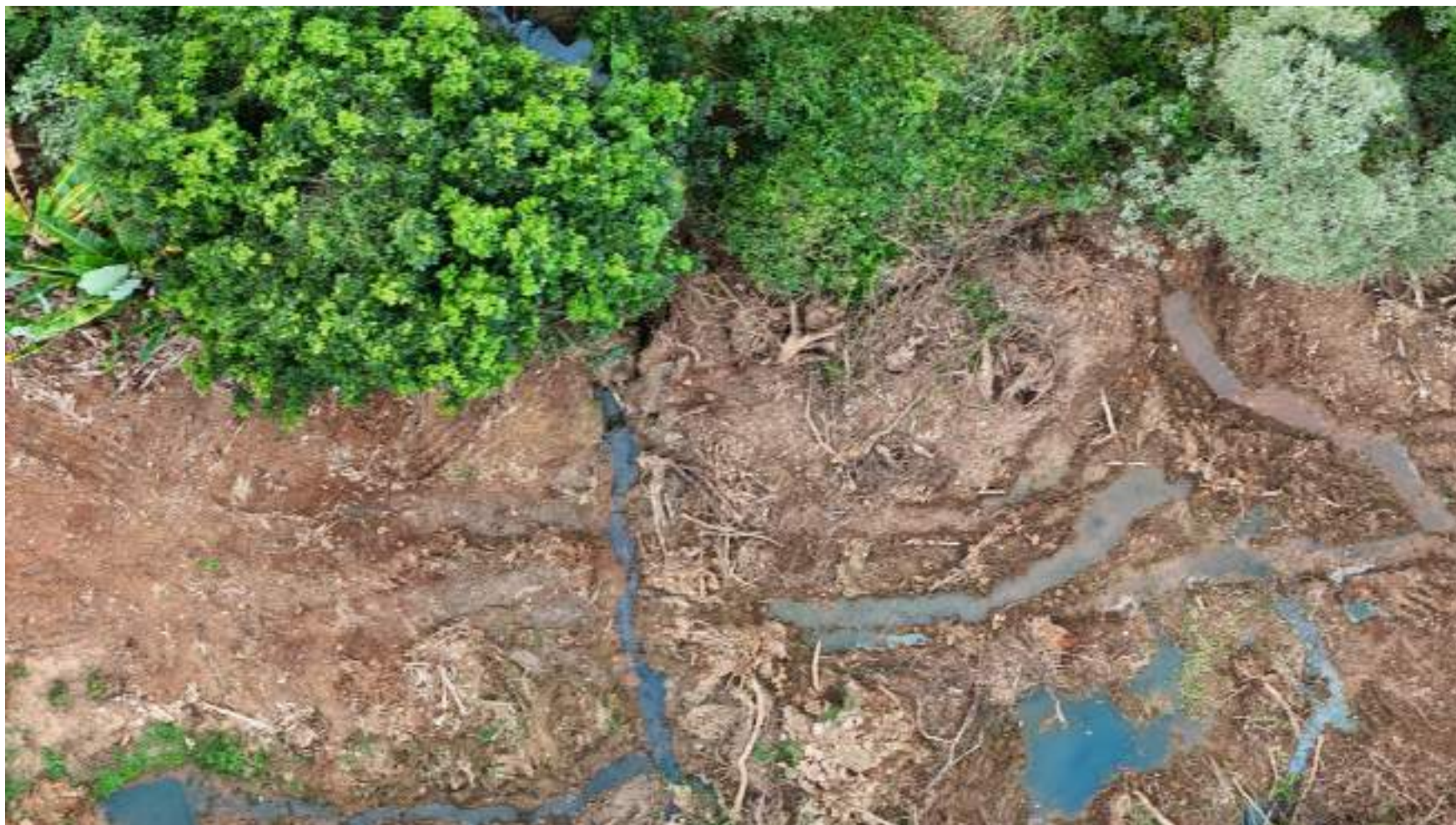
Foto 23 — Vista complementar — registro fotográfico do trecho extremo do emissário para finalização do levantamento de campo.
