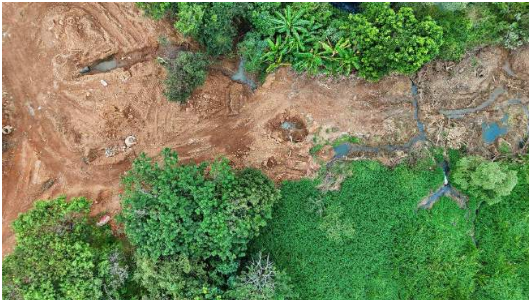
Foto 09 — Vista do trecho central — evidenciação dos extravasamentos de esgoto e degradação da tubulação ao longo do corredor de intervenção.
