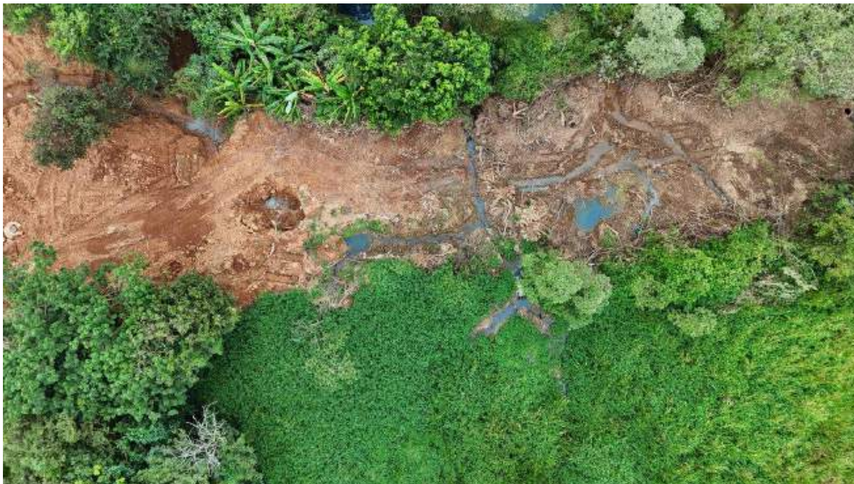
Foto 14 — Detalhe do PV de interligação — poço de visita com acúmulo de efluente ao redor, evidenciando avaria e necessidade de substituição imediata.
