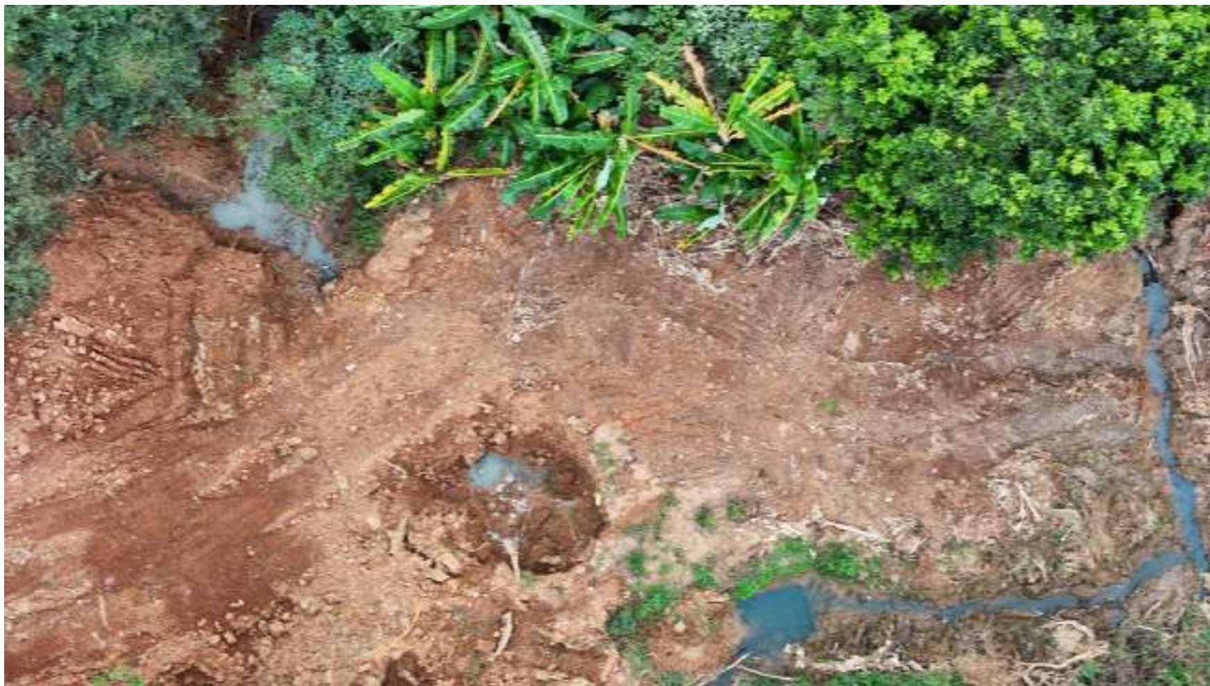
Foto 17 — Vista oblíqua do trecho de intervenção — detalhe da vala escavada, solo removido e poço de visita exposto para execução dos serviços.
