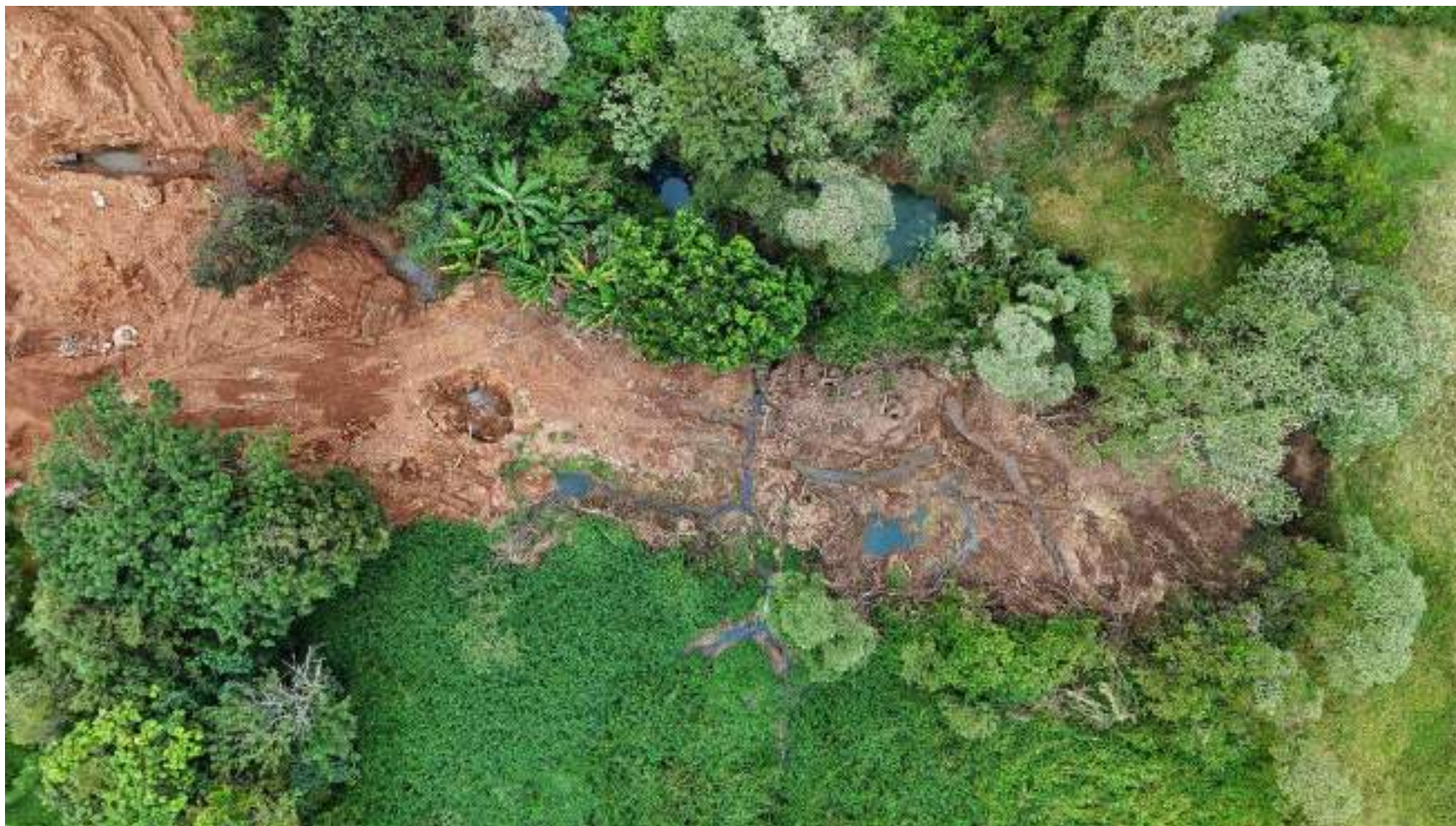
Foto 05 — Área de trabalho — detalhe da frente de escavação, marcações de máquinas e poços de visita (PVs) aflorando após limpeza do terreno.
