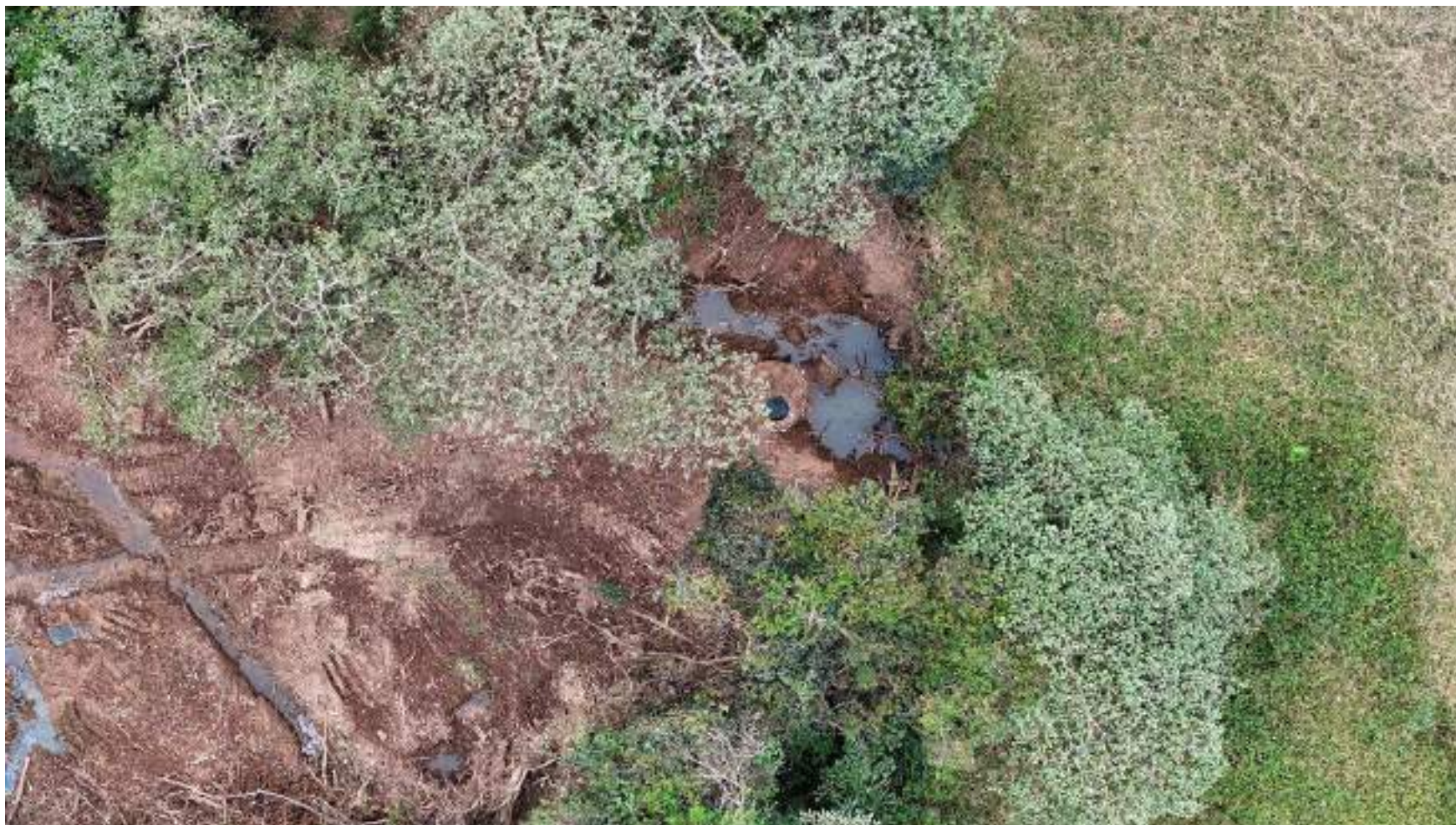
Foto 21 — Vista complementar — registro das marcações de escavação e da frente de serviço para fins de documentação técnica.
