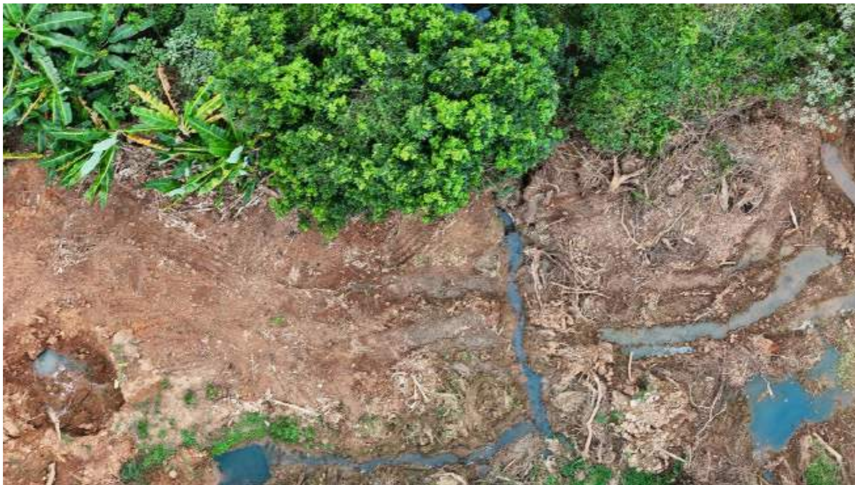
Foto 18 — Detalhe do poço de visita — PV existente exposto após escavação, com marcação para assentamento e conexão da nova tubulação PEAD.
