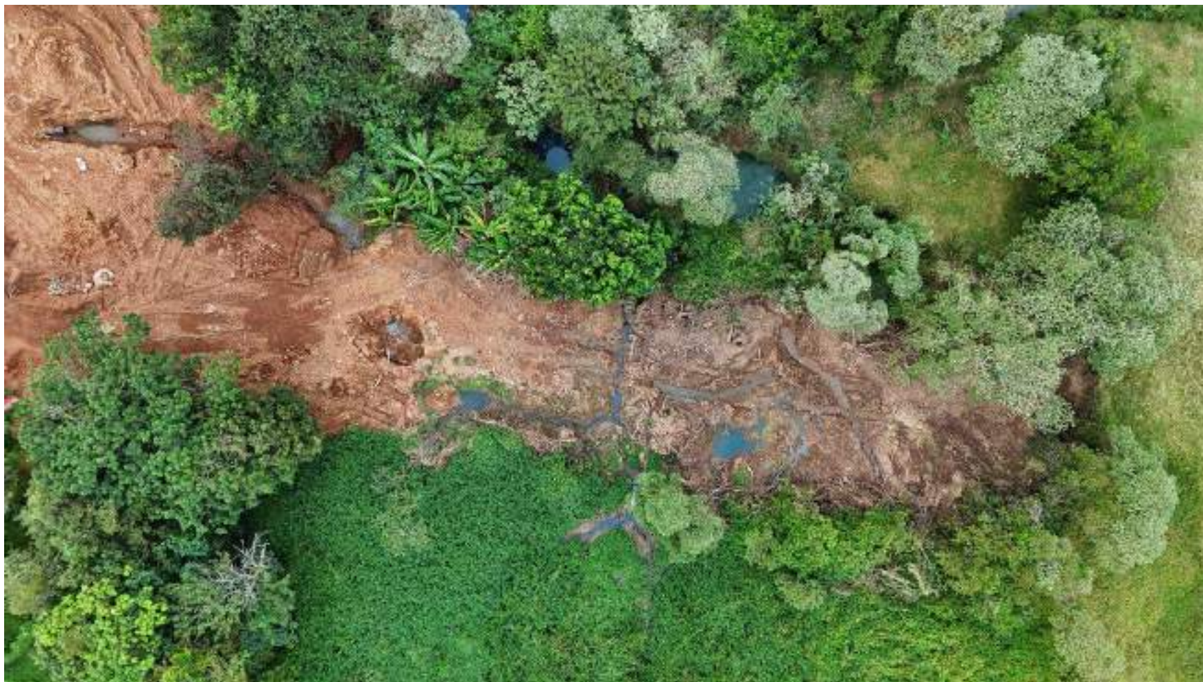
Foto 02 — Vista aérea geral do trecho — continuação do levantamento de campo, evidenciando acúmulo de efluente sobre o solo.
