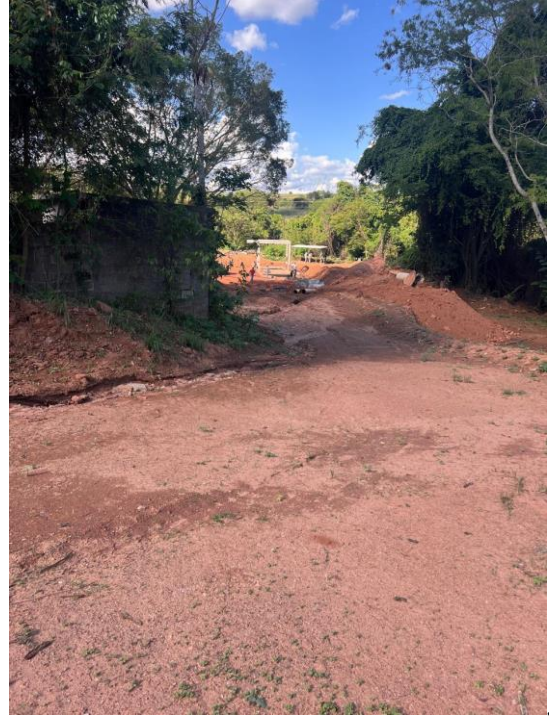
Figura 2. Local a ser executado a obra com vista da EEE São Domingos ao Fundo.
