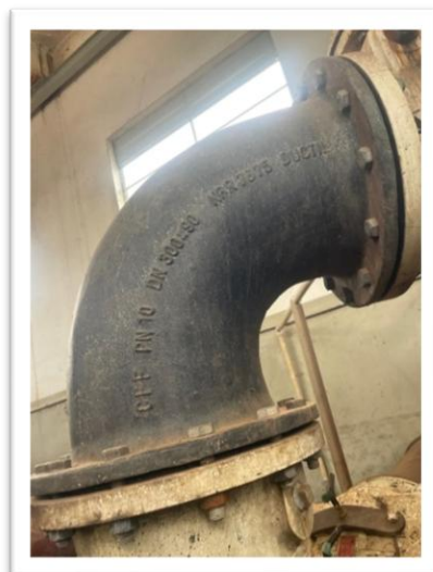
Curva em ferro fundido, PN 10 DN 300 x 90 graus
