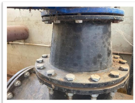
Redução, em ferro fundido, 400 x 300 x 28,5.
