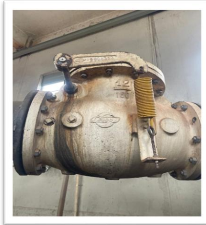
Válvula de retenção de esgoto 69,5 x 300 em ferro fundido, flangeada.
