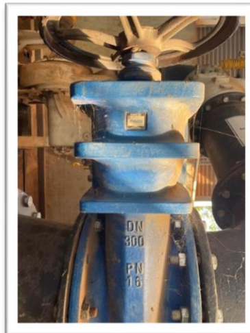
Registro de Gaveta Flangeado com cunha revestida e emborrachada GTW
